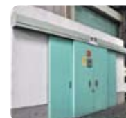
フロン保管庫 ボンベに回収されたフロンを適切な温度で保管する専用庫。
